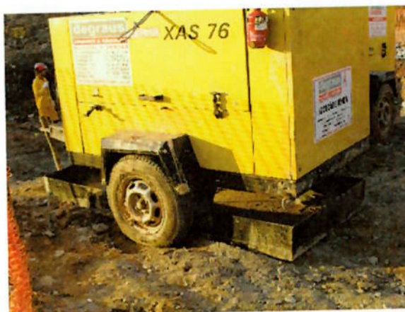
Figura 14 – compressor portando bacia de contenção metálica
