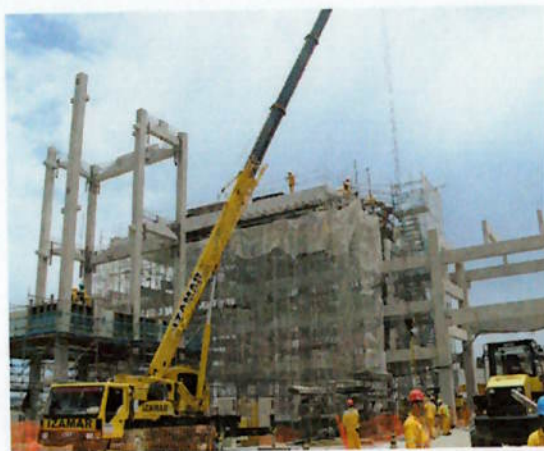
Figura 6 – trabalho em altura envolvendo movimentação de cargas.
