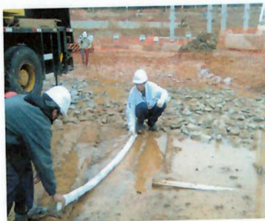
Figura 13 – contenção de óleo utilizando barreira móvel e material absorvente
