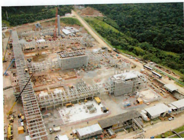
Figura 8 – Vista geral da obra
